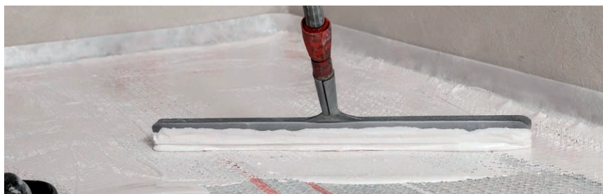
FOT. 1 System THERMOPAL służy do szybkiej renowacji krytycznych i spękanych powierzchni
