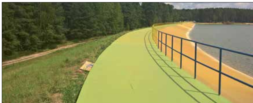
▲ Fot. 2. Renowacja ciągu komunikacyjnego na zaporze
