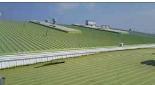
▲ Fot. 1. Renowacja pokrycia dachu z blachy
