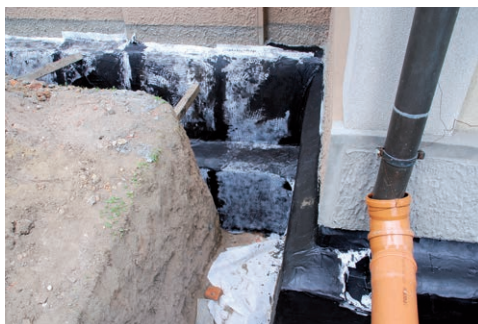
Fot. 4. Izolacja bitumiczna COMBIDIC z wklejoną flizeliną ochronną
