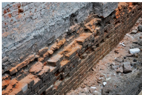
Fot. 2. Ściana fundamentowa z cegły
